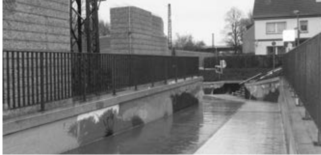
An der Bahnunterführung wächst die Lärmschutzwand.
