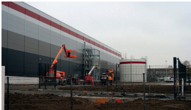
Etwa sechs Monate hat es gedauert, die Halle zu errichten
