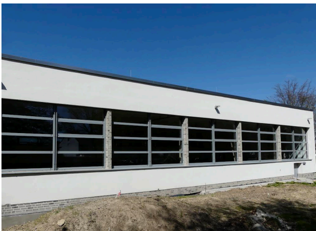
Die Turnhalle der Jahnschule wurde von Grund auf saniert.
