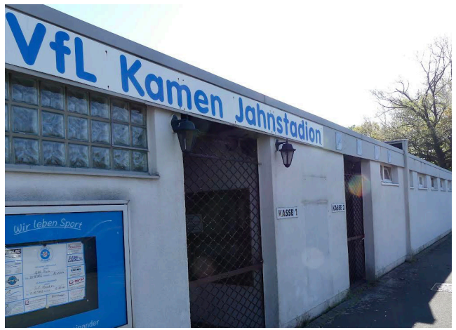
Die Umkleidekabinen im Jahnstadion des VfL werden in den kommenden Monaten modernisiert und energetisch fit gemacht.
